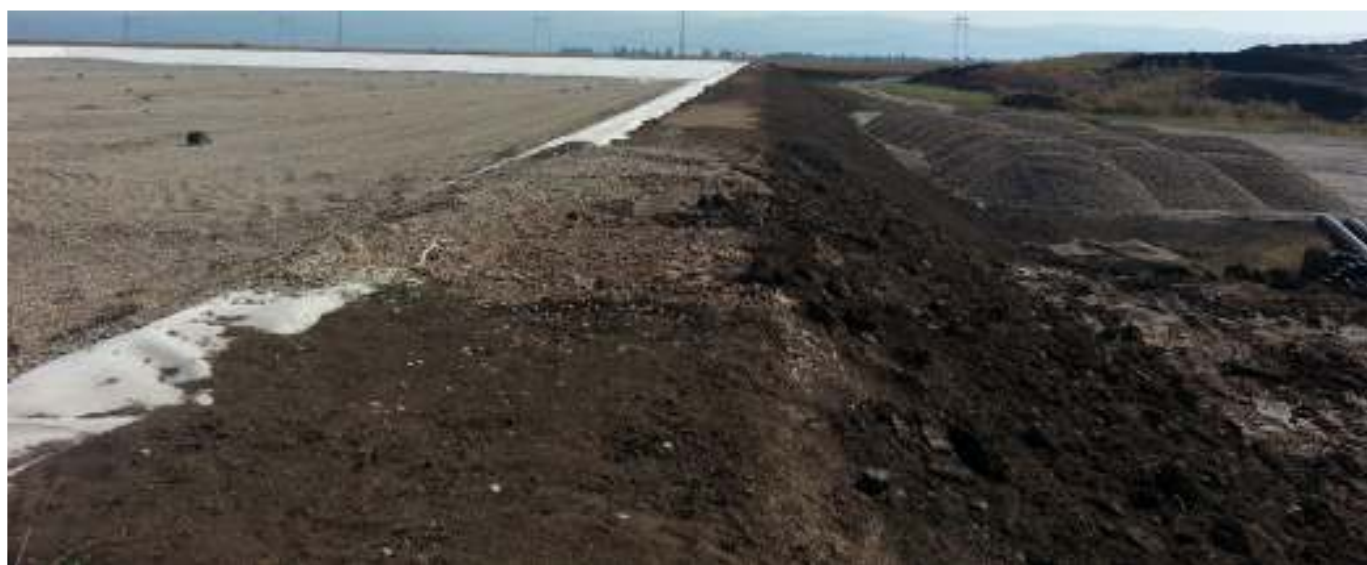
Figura 3 materiale geosintetice instalate in tranșeea de ancorare celula 1 dig Sud – Vedere Vest
