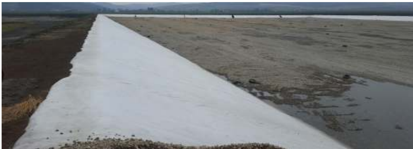
Figura 4 materiale geosintetice instalate in tranșeea de ancorare celula 1 dig Sud – Vedere est
